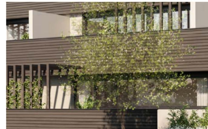
**Mehr als Fassade** – eine lasierte, hinterlüftete Holzfassade dient der optimalen Wärmedämmung und dem edlen Erscheinungsbild der Außenhaut.
