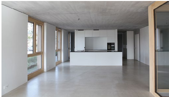
Stylisch und alltagstauglich: Sichtbeton und Anhydrith-Fließestrich.
